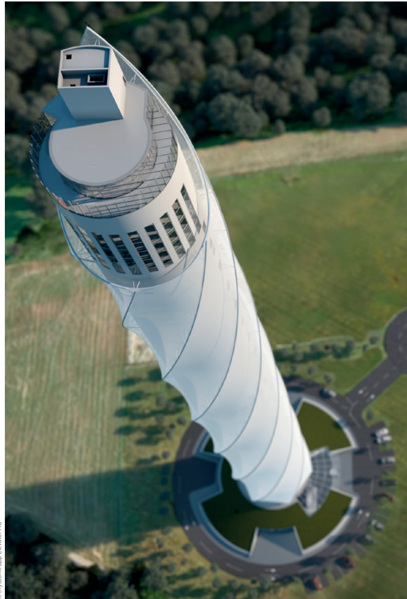
Jüngstes Beispiel für den Textil-Faser-Einsatz am Bau erhält den Balthasar Neumann Preis: thyssenkrupp Testturm in Rottweil.
